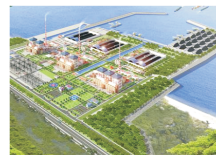
▲ 越南永新 (重油启动锅炉)
